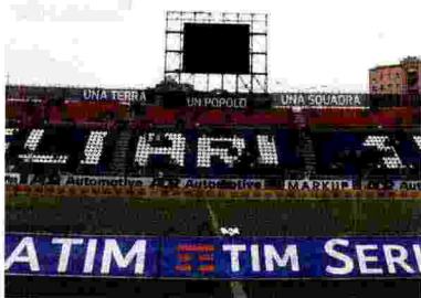
La Sardegna Arena, stadio temporaneo costruito in 4 mesi
